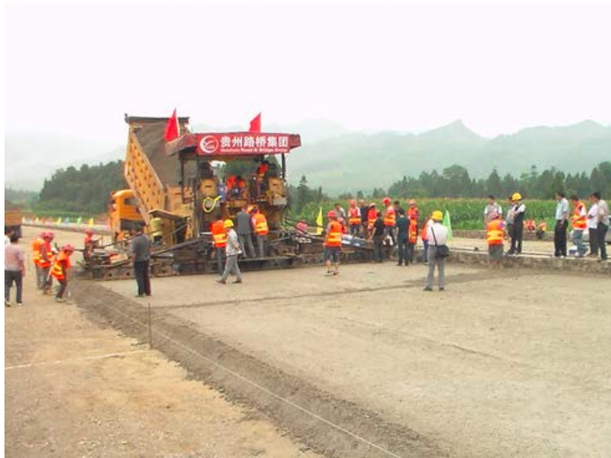
水泥稳定土-路基
